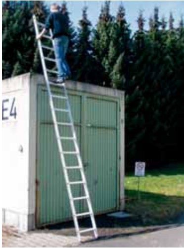
Bild 40: Übersteigen von der Anlegeleiter
