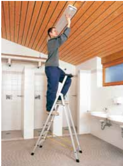
Bild 43: Sicherer Stand auf der Stehleiter mit Plattform
