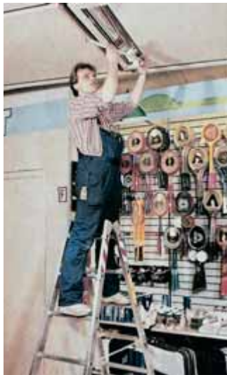
Bild 44: Sicherer Stand bei Über-Kopf-Arbeiten
